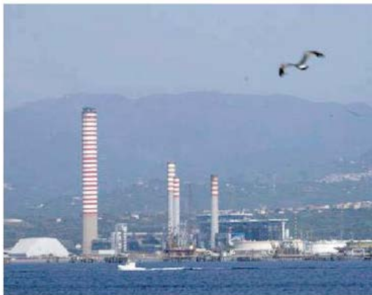
Edipower. La centrale elettrica darà spazio ad altri impianti
